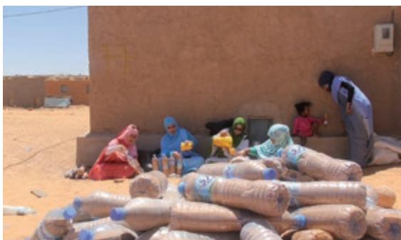
Femmes remplissant des bouteilles en plastique avec du sable pour les utiliser comme briques de construction. Crédit Ecosahara et www.theswitchers.eu
